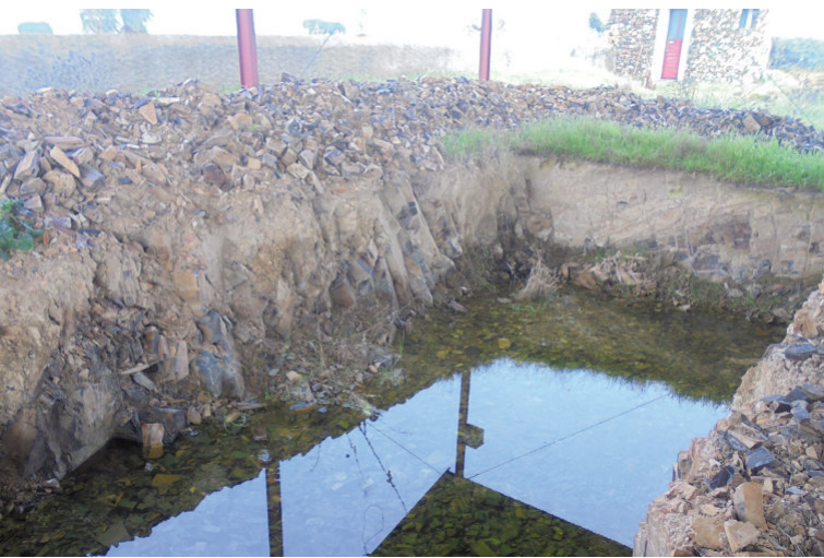
Etang en construction à Herdade das Cebolas, Campinho, Portugal. (Janeiro, 2018).
