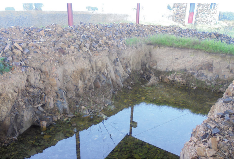
Rakenteilla oleva lammikko Herdade das Cebolasissa, Campinho, Portugali (tammikuu 2018)
