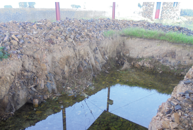
Pond under construction at Herdade das Cebolas, Campinho, Portugal. (Janeiro, 2018).
